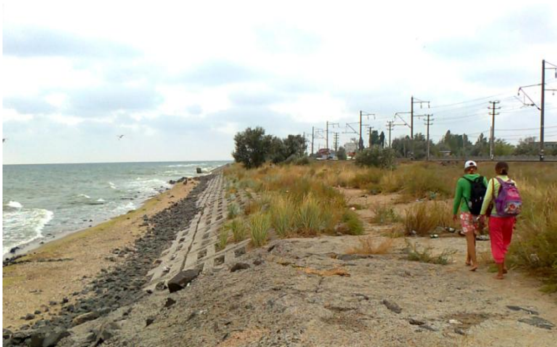
Искусственная терраса защищает железную дорогу от разрушительного влияния штормовых волн. В регулярных полевых наблюдениях принимают участие студенты физико-географы (2013 год)
